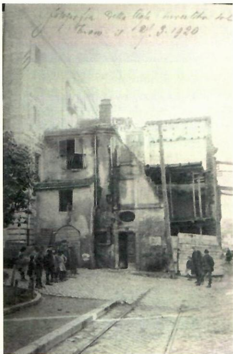
Fig. 1. L'edificio colpito dal tram e il binario cieco senza respingenti.
