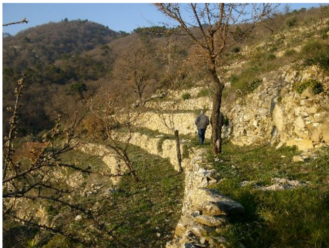
Foto 10. Versante terrazzato da ripristinare.
